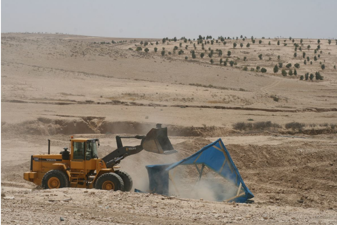
الصورة 2: عملية هدم في العراقيب، 25 آب 2011 (تصوير: منتدى تعایش)
